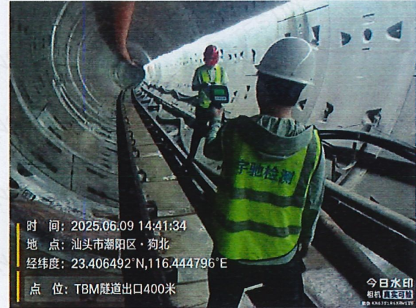
TBM 隧道洞口出口 400 米处
