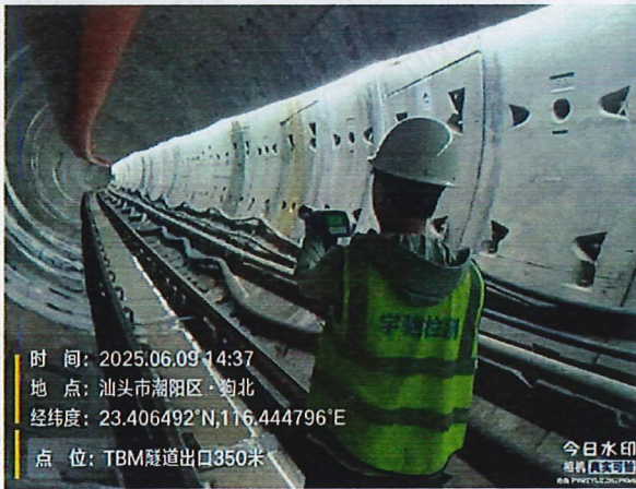
TBM 隧道洞口出口 350 米处
