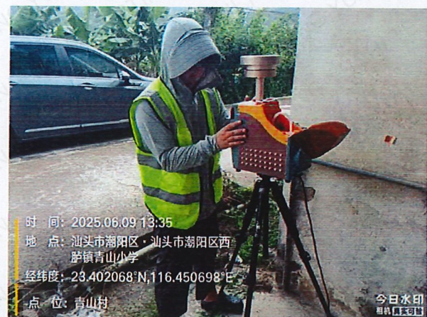
青山村 (TBM 出口)
