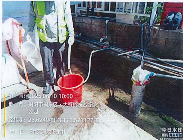
施工 1 标 3#支洞地下水井
